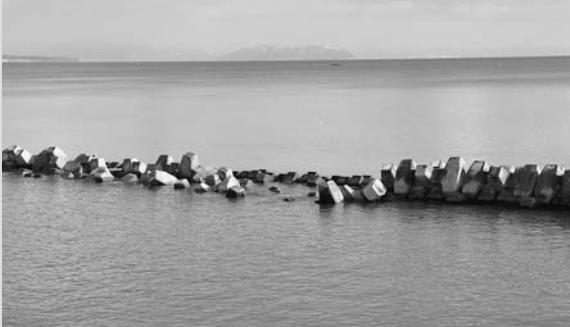
高波による離岸堤崩落(中ノ川地区)
