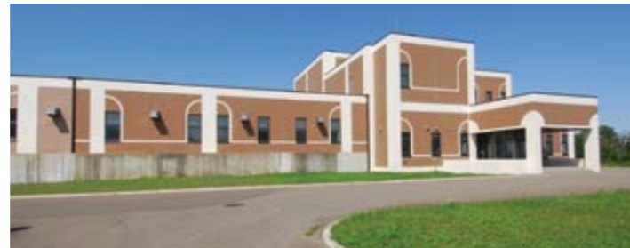
下水道処理施設「クリーンセンター」
