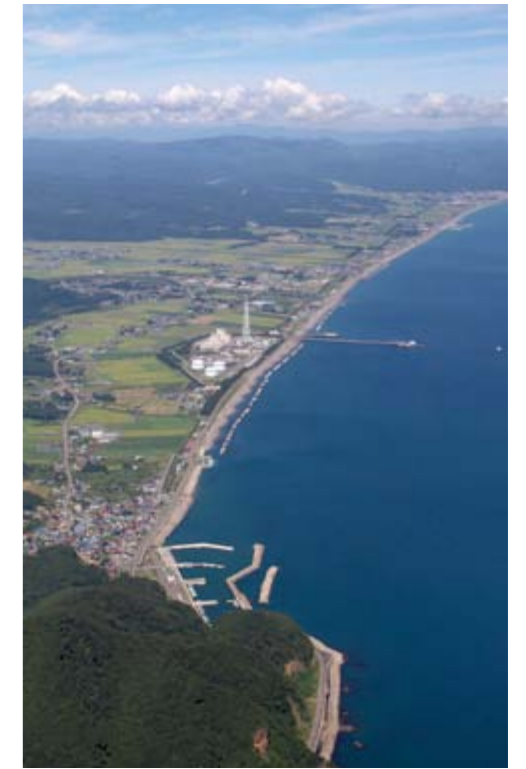
涌元漁港から中の川方面に延びる海岸線 (中央は北海道電力知内発電所)
